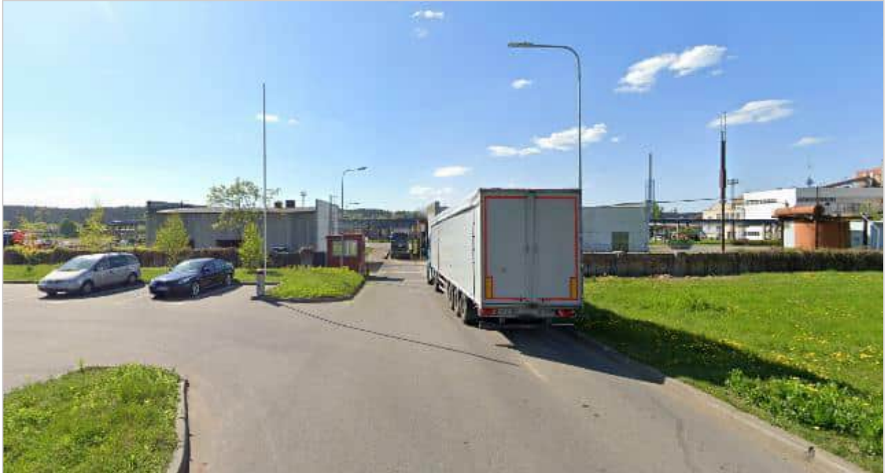
75 pav. Įvažiavimo į Vilniaus termofikacinės elektrinės Nr. 2, Elektrinės g. 2, Vilnius teritoriją nuotrauka 165
