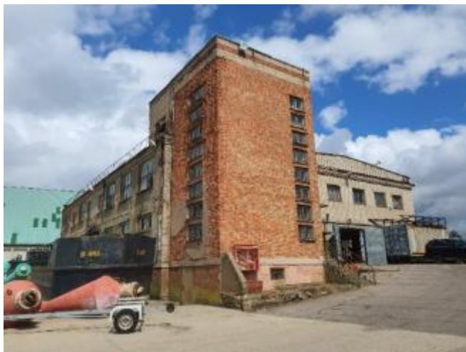
71 pav. Nemuno g. 40, Klaipėdoje buvusio pastato archyvinė nuotrauka iš krantinės pusės šiaurės kryptimi
