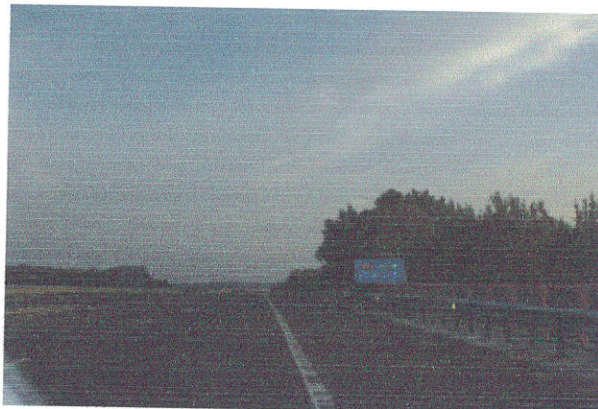
1. Kelio A13 rekonstrukcijos pradžia 12,1 km, iš P pusės
